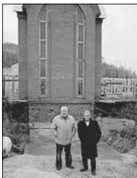
На стройплощадке часовни.
